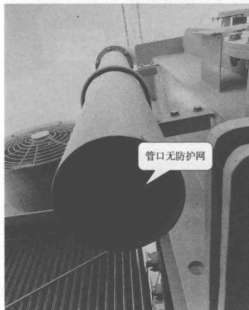
图 1-10 事故放油阀管口无防护网
