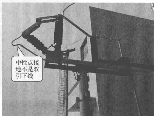
图 1-16 主变压器中性点隔离开 关转动部分单根接地引下线
