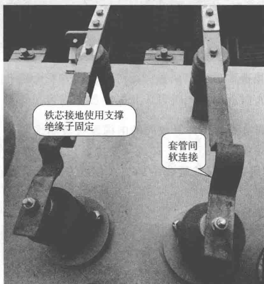
图 1-5 套管间正确接线方式
