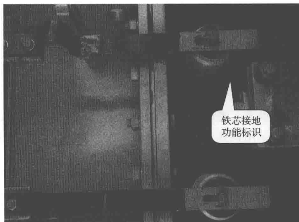
图 1-2 变压器铁芯夹件标识
