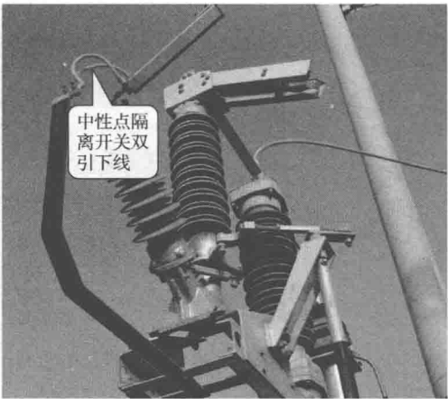
图 1-17 中性点隔离开关转动部分使用双引下线
