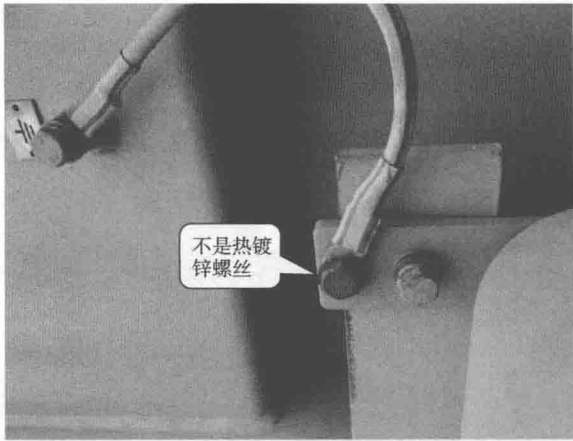
图 1-18 主变压器上紧固螺丝不是热镀锌螺丝
