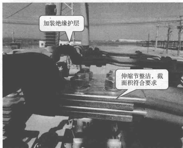
图 1-9 标准的母线桥伸缩节
