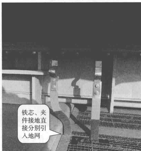
图 1-3 铁芯、夹件接地直接引入地网
