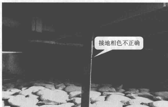
图 1-14 主变压器接地相色不符合要求、
