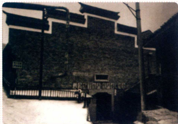
解放初期，在原恒兴烧房旧址上建成的茅台酒厂制酒一车间三、四班生产房
