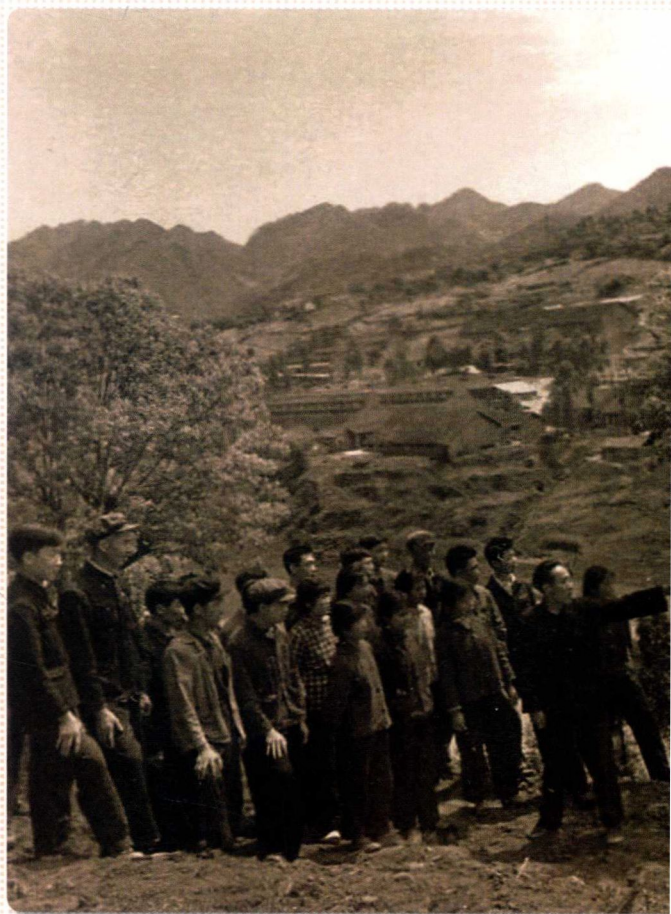
1965年，茅台酒厂召开扩建工程现场会
