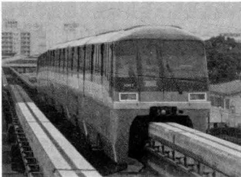
图 1.4 日本东京单轨羽田空港线 （東京モノレール羽田空港線）
