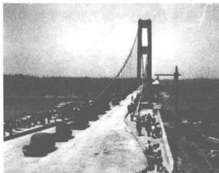
图 1.1 塔科马海峡大桥通车当日的情形
