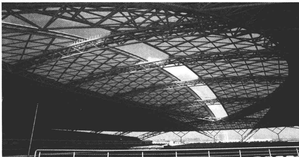
图 1-6 南通体育会展中心开闭式屋盖
