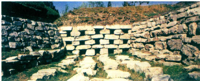
齐临淄城排水口
