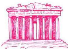
人如果在望向一排立柱时，往往会觉得边角的柱子看起来更细，并有向外侧倾斜的感觉。因此，帕特农神庙正面的一排圆柱中，最外侧的两根柱子设计得比其他圆柱略粗，且微微向内倾斜。这也是为了呈现出完美的观感而采用的一种视差矫正法。
