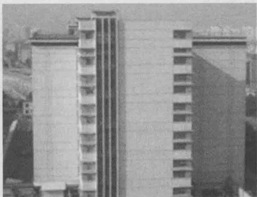
图 1.2 某土建库实景
