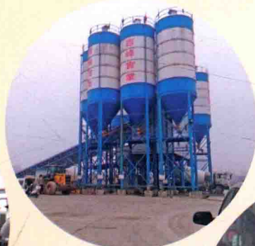
安康市汉滨区吉峰混凝土有限公司生产设备
