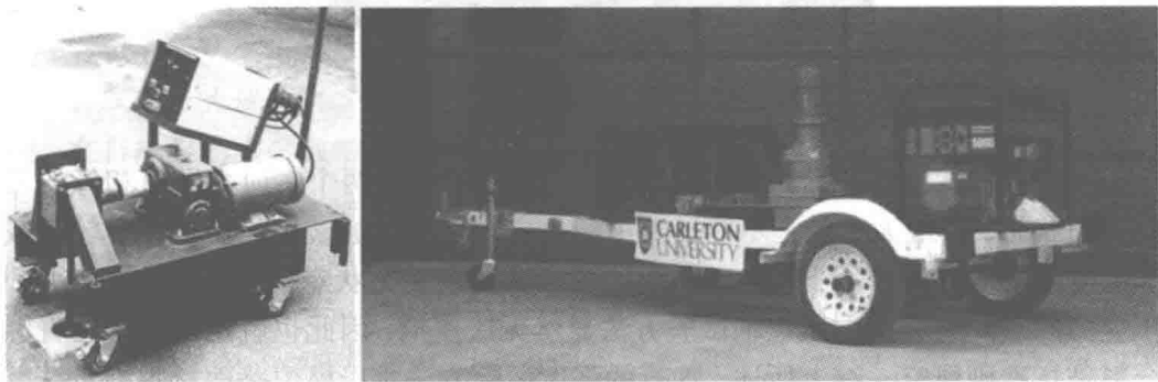
图 1-1 第一代(左)和第二代(右) Carleton 现场剪切试验设备
