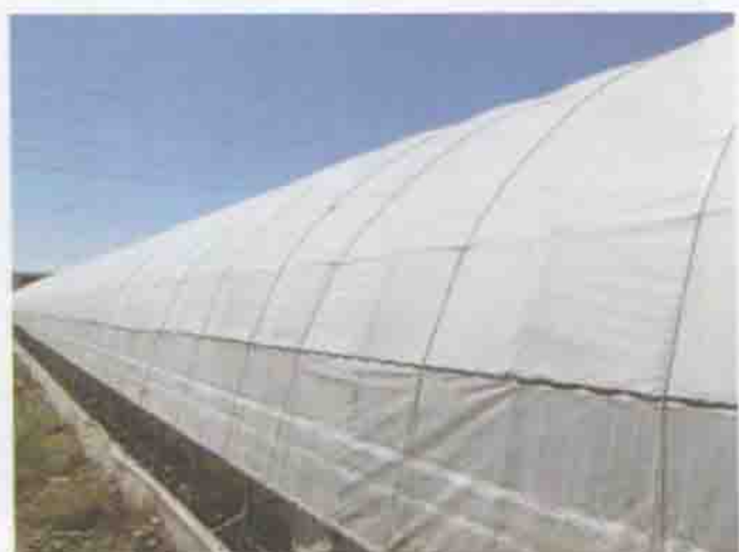
彩图 11 用专业遮阳降温涂料利索喷涂棚膜进行遮阳降温
