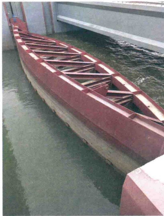
图 1-7 双拱曲面钢闸门挡水控制运行
