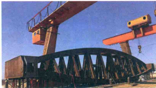
图 1-6 双拱曲面钢闸门门叶结构组装图
