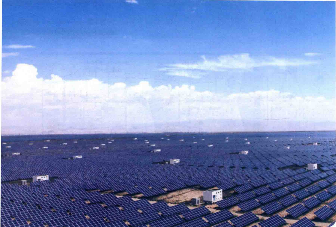
图1.3 海南州生态光伏发电园区
