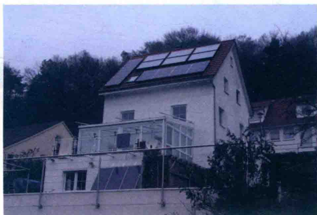
图1.2 德国屋顶光伏电站
