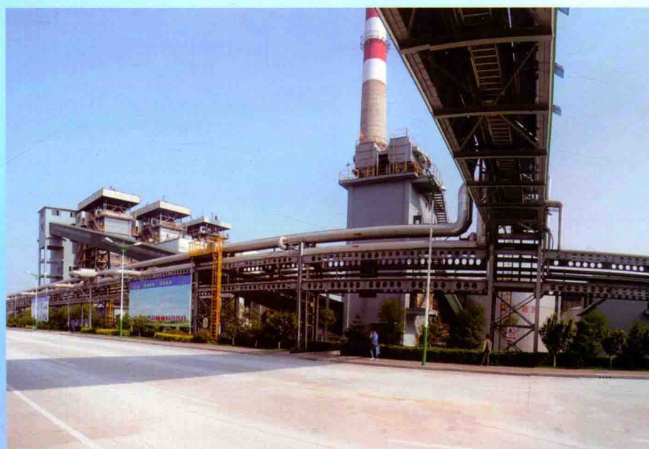
鄂尔多斯能化荣信化工项目全系统贯通投产。这是目前世界上最大的水煤浆气化装置，碳转化率达到98%以上，有效气体成分转化率达到82%至85%，气化技术达到国际领先水平
