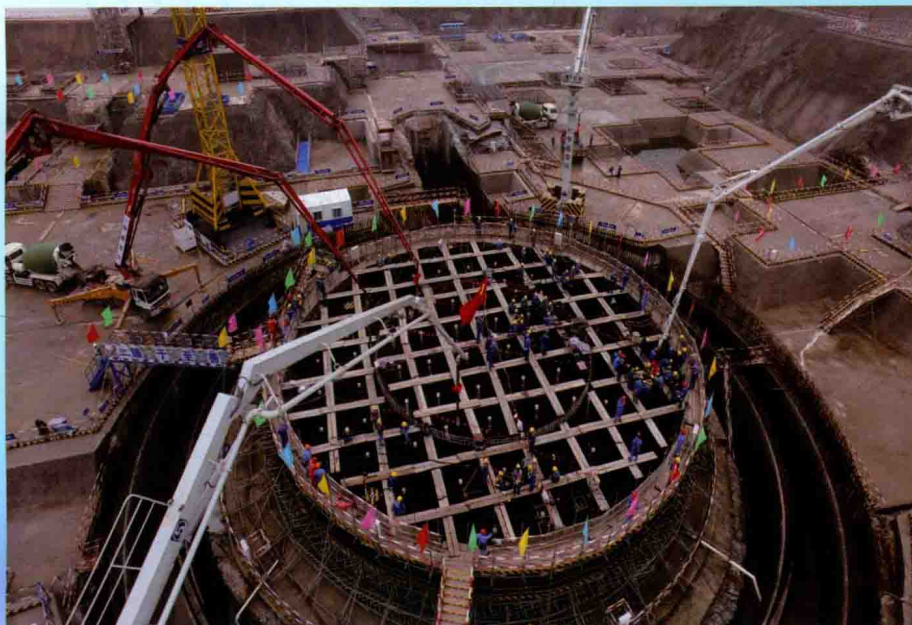
2015年12月，防城港3、4号“华龙一号”三代核电技术示范机组项目开工建设
