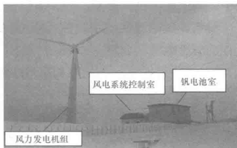
图 1-3 日本 SEI 北海道 Tomari 170kW × 6h 储能系统用于改善新能源功率输出
