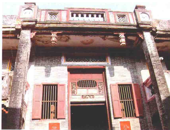
琼海南洋风格建筑 摄影：张一平 2015 年
