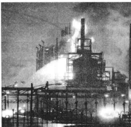
(b)茂名石化乙烯裂解装置火灾
