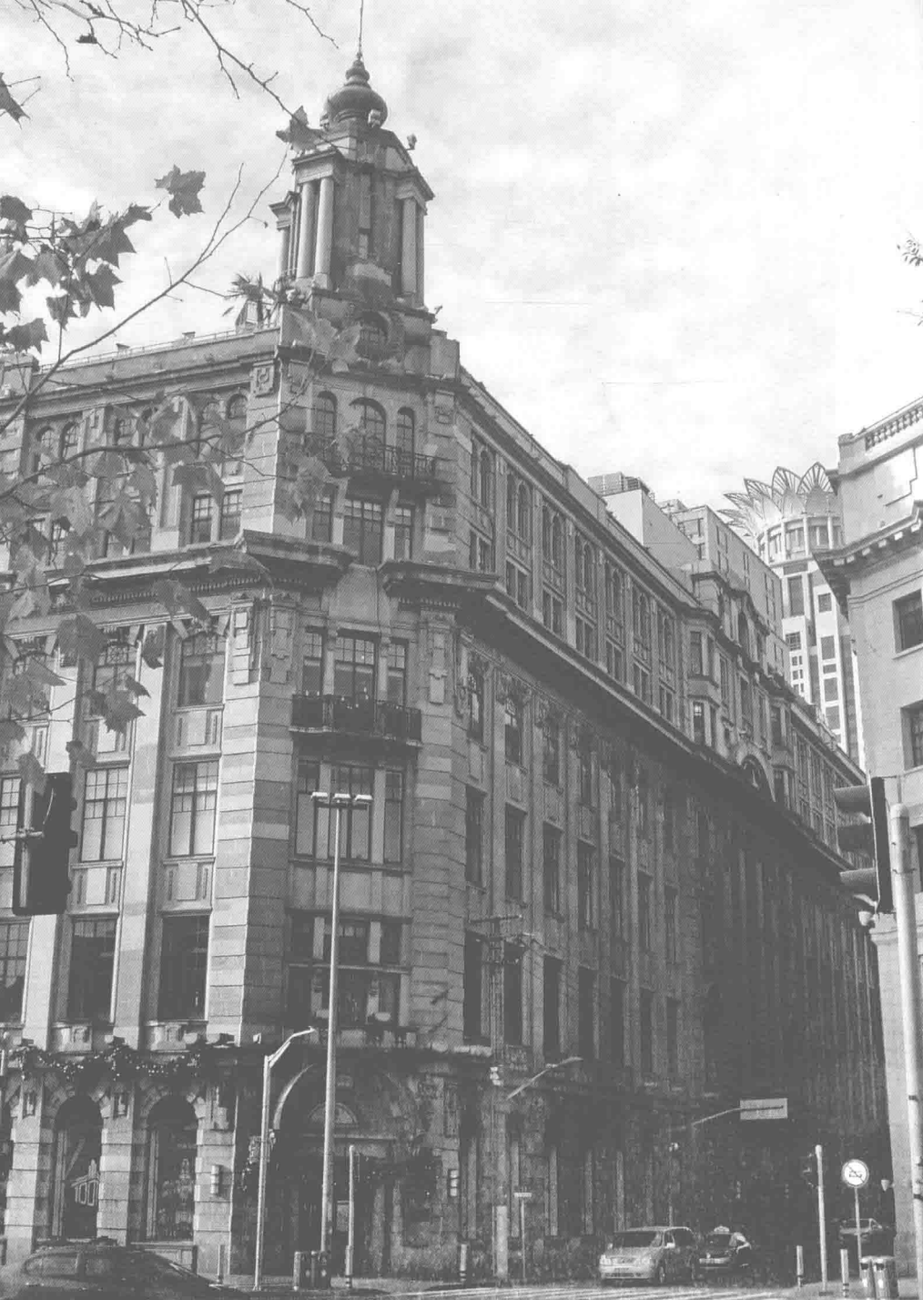
混合大楼的傲气：挺拔的塔顶，微转的身姿
