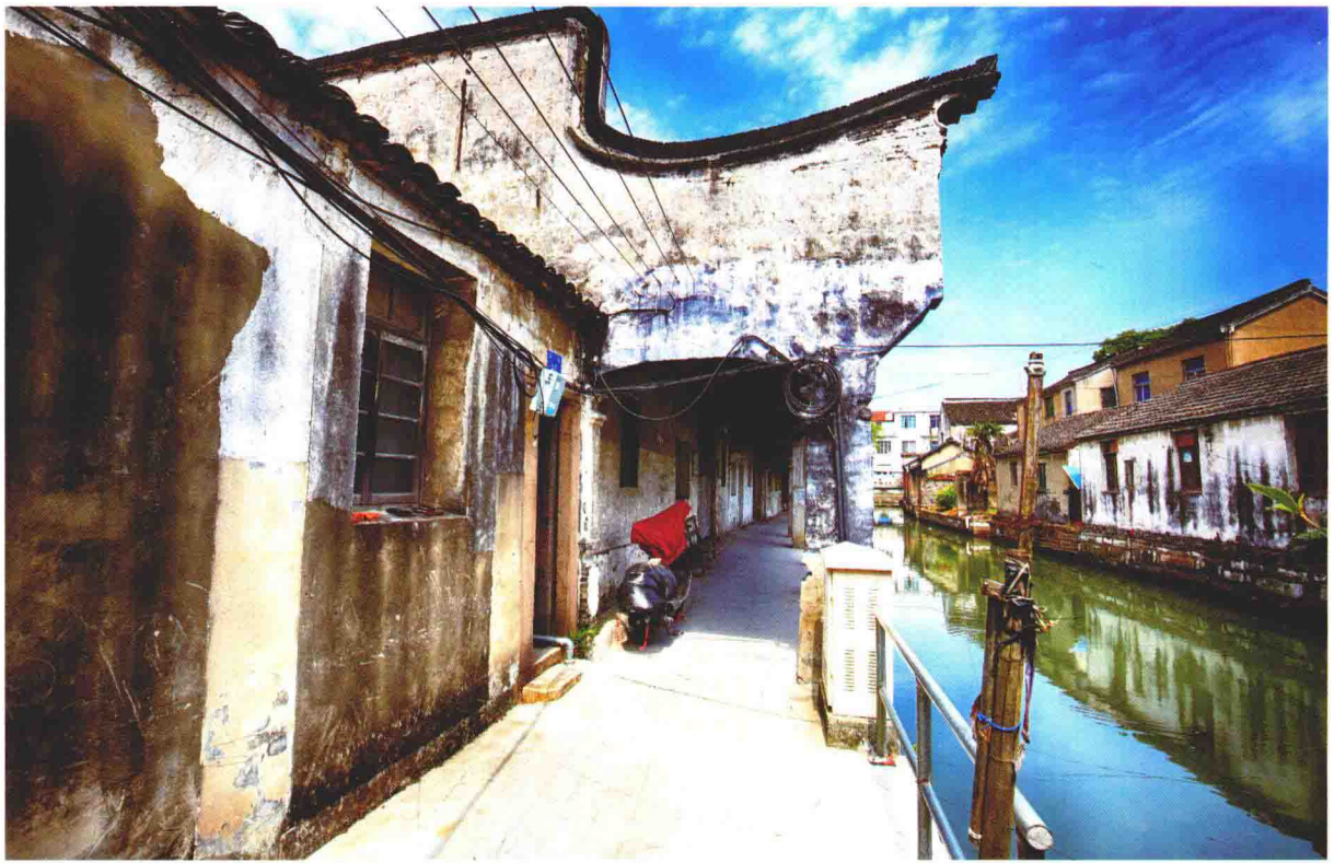
实景三 黎里镇芦墟跨街楼
