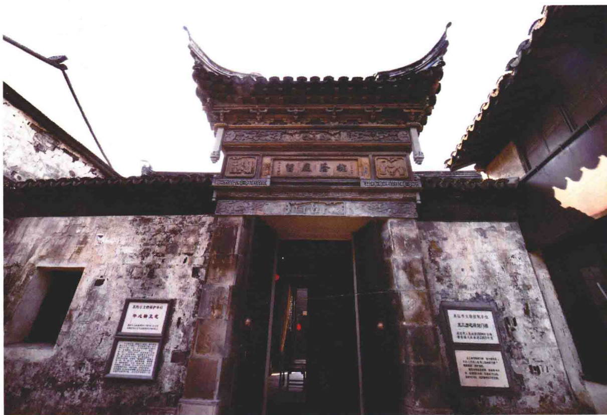
黎里镇中心街王宅
