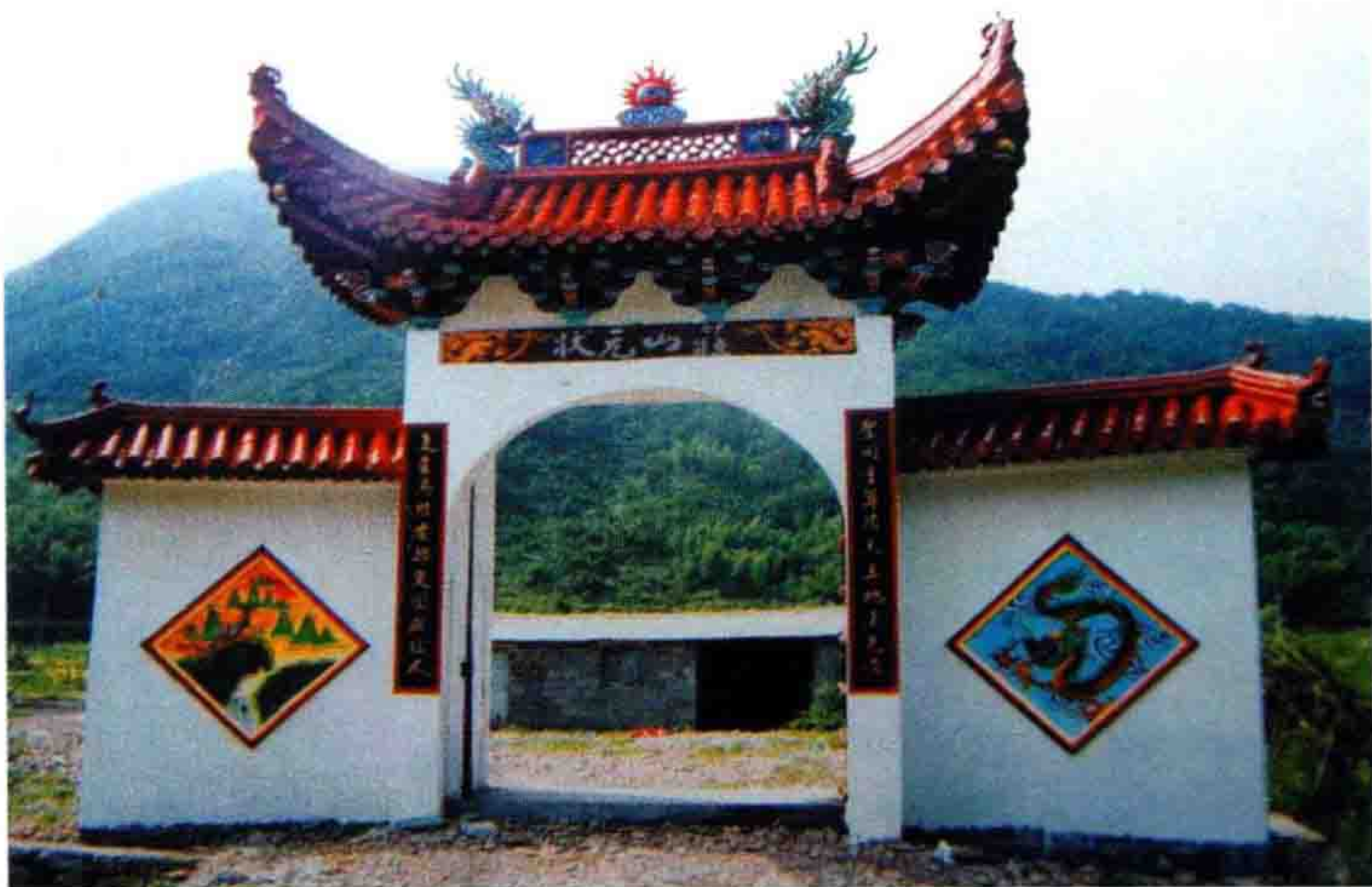
▲ 正在建设中的乐清梅溪故乡状元山庄门楼。（叶松开摄）（图 24）
