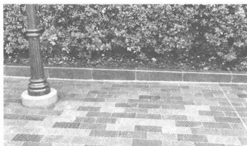
图 1-14 某园区路边锯齿形边沟
