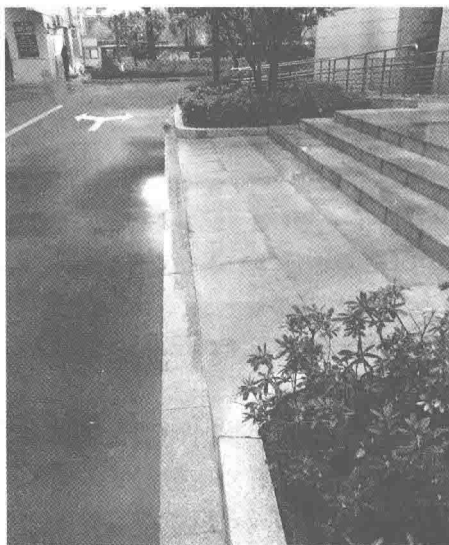
图 1-7 某设计院内部道路积水情况
