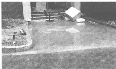
图 1-8 某设计院内部引道积水情况
