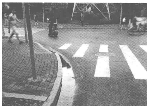
图 1-6 道路交叉口积水情况
