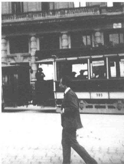
古斯塔夫·马勒前往维也纳宫廷歌剧院途中，1920年该歌剧院正式更名为维也纳国家歌剧院。照片摄于1904年。
