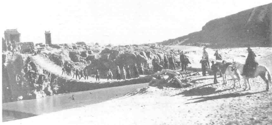
照片 10 架设后的普济桥。对岸断崖上有纪念碑。
