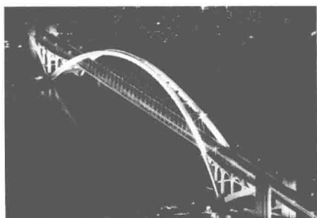
图 1-3 上海卢浦大桥
