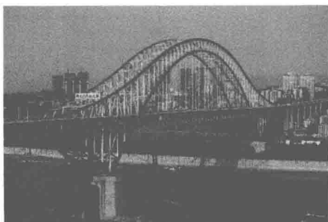
图 1-4 重庆朝天门长江大桥
