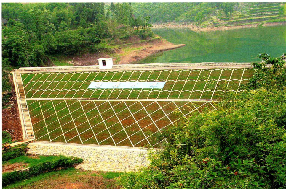
· 2003 年治理后的乌江镇堰桶水库
