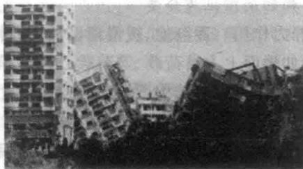
图 1-2 地震作用造成房屋倒塌
