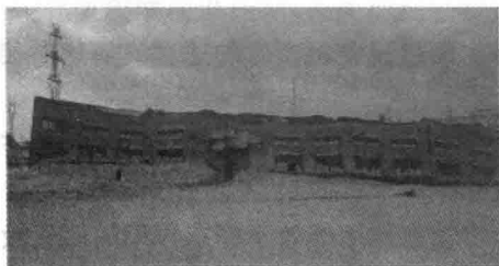
图 1-1 雪荷载造成的轻钢厂房垮塌
