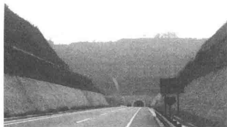
图 1-7 铜黄公路黄土边坡 全坡面植草防护
