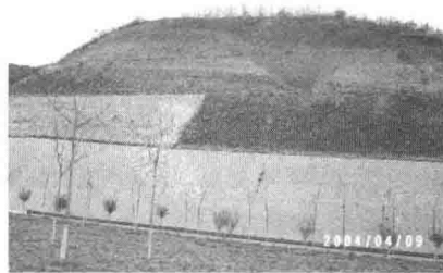
图 1-8 铜黄公路罗圈梁隧道 黄土边坡护面墙
