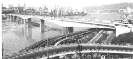
图 1.1 重庆石板坡长江复线桥
