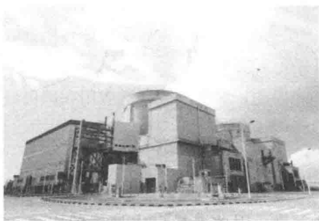
图 1.7 广西防城港核电站
