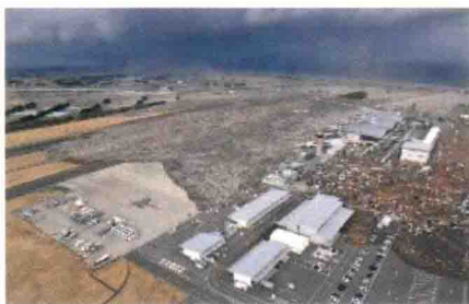
(a) 海水涌入机场,毫无阻挡
