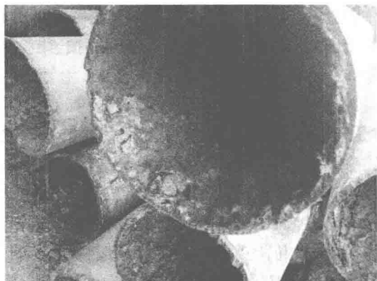
图 1-6 某水工金属管路腐蚀图
