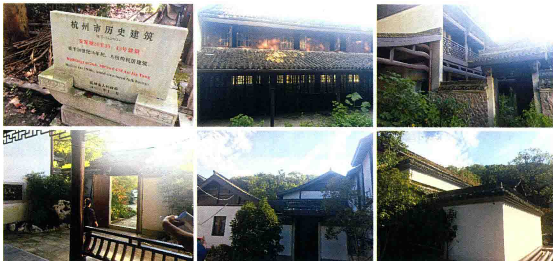
图4 杭州玉皇山南基金小镇木结构建筑改造前
