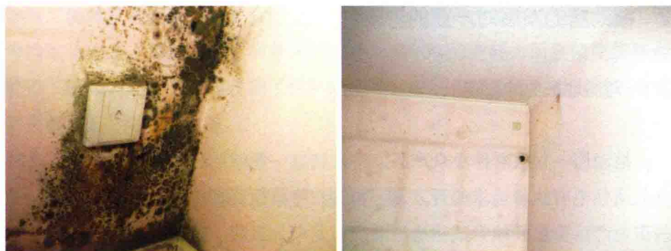
图6 多高层居住建筑中的单元房家居改造前
