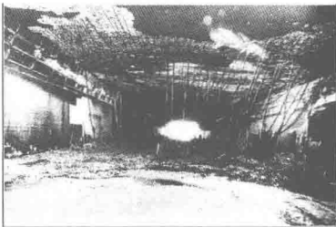
图 1-1 Moorfleet 隧道火灾
