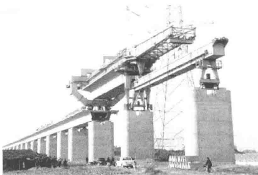
(b) 中国京沪高铁桥梁预制节段梁
