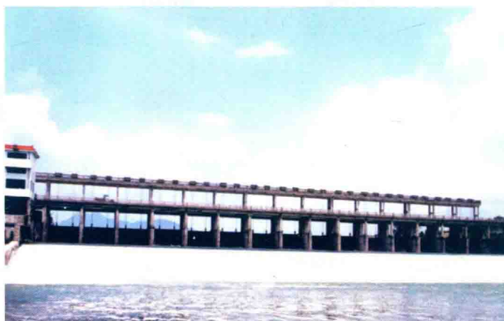
彩图 4 乌石拦河闸阶梯陡坡段运行流态
