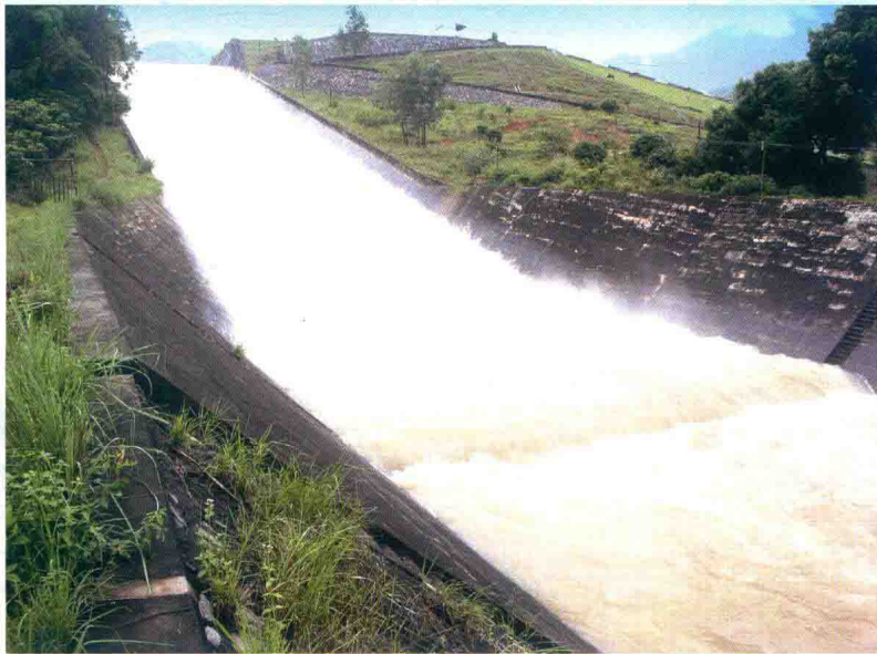
彩图 1 稿树下水库阶梯溢洪道泄洪运行流态
