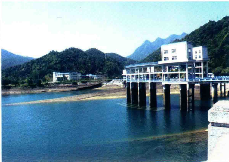
彩图 16 广州抽水蓄能电站下库进出水口
