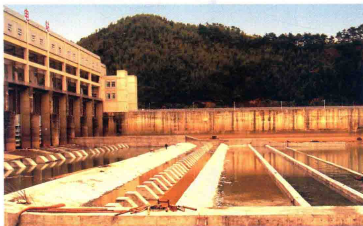
彩图 13 东山水闸（4号~12号闸孔）除险改造工程施工
