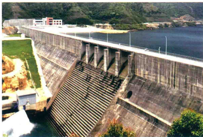
彩图 9 台山核电水库阶梯式溢流坝
