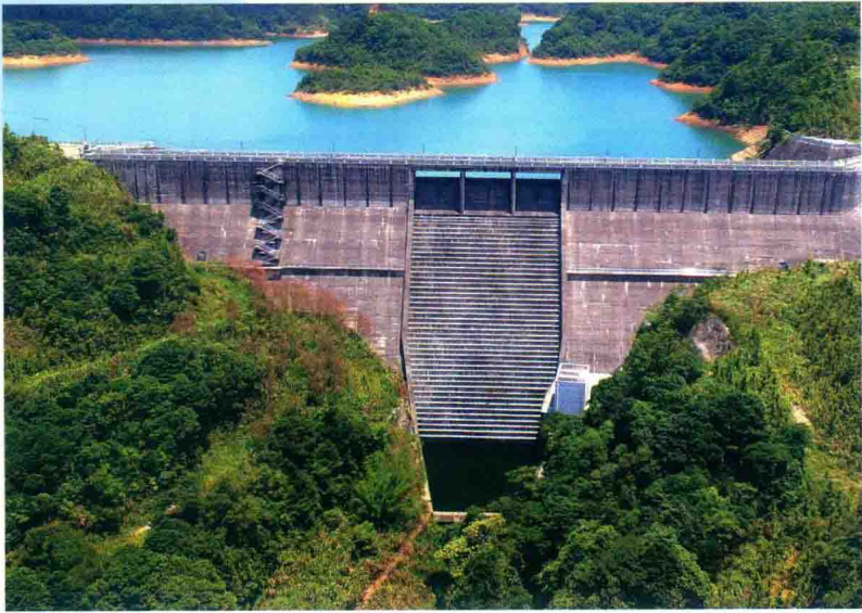
彩图 10 惠蓄电站上库阶梯式溢流坝
