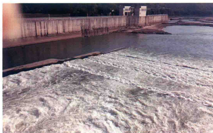
彩图 14 东山水闸（4号~12号闸孔）除险改造后运行流态
