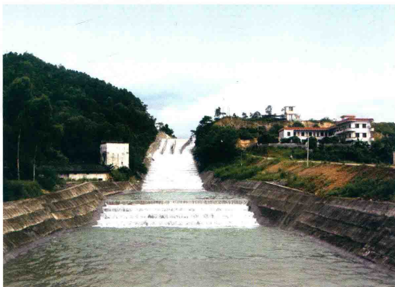
彩图 2 黄山洞水库阶梯溢洪道泄洪运行流态
