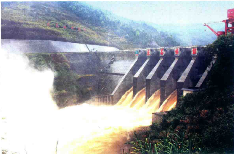
彩图 23 乐昌峡水电站溢流坝泄洪流态
