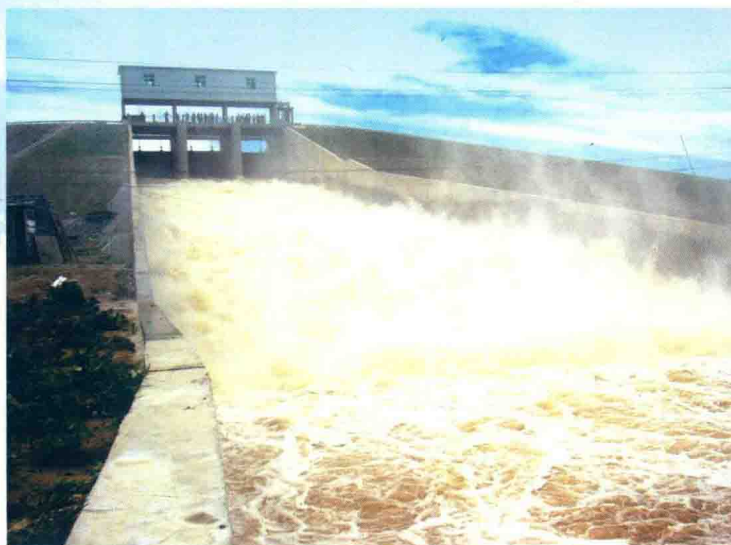
彩图 6 秋风岭水库溢洪道除险改造后运行流态
