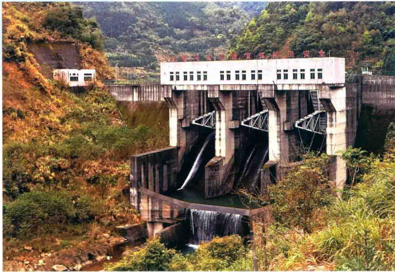
彩图 24 杨溪水三级水电站溢流坝
