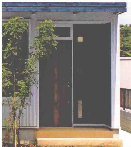
成品的隔热门 + 铺装木板
