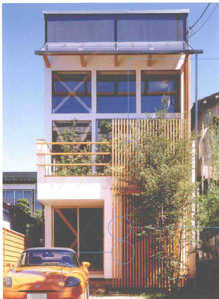
纵向百叶的构成和效果。纵向百叶兼作二楼栏杆，一楼百叶后面就是玄关
