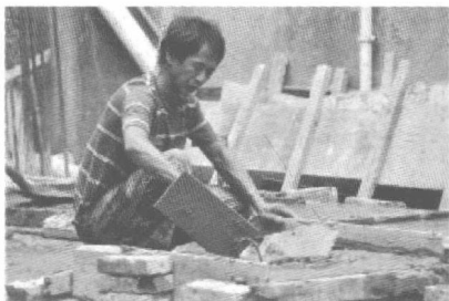
图 1-5 旧照片中瓦工制作构件情景
