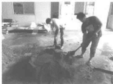
图 1-6 瓦工搅拌水泥情景
