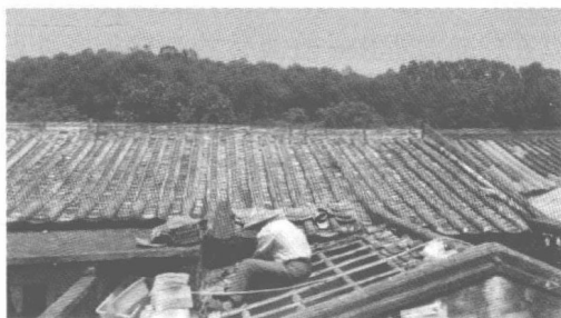
图 1-9 瓦工在屋面铺瓦情景
