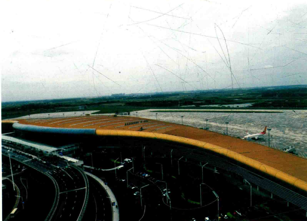
2012年底，合肥新桥国际机场全面建成
