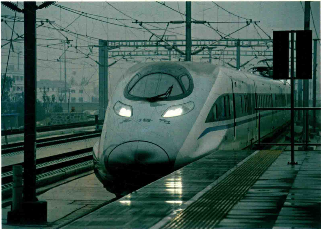
10月16日，合肥至蚌埠高速铁路正式开通运营。合肥至蚌埠高速铁路是京沪高铁与沪汉蓉客运专线间的高速连通线，也是北京至福州客运专线的组成部分。该项目于2009年1月开工建设，运营里程132公里，设计时速350公里，运营初期按时速300公里运行
