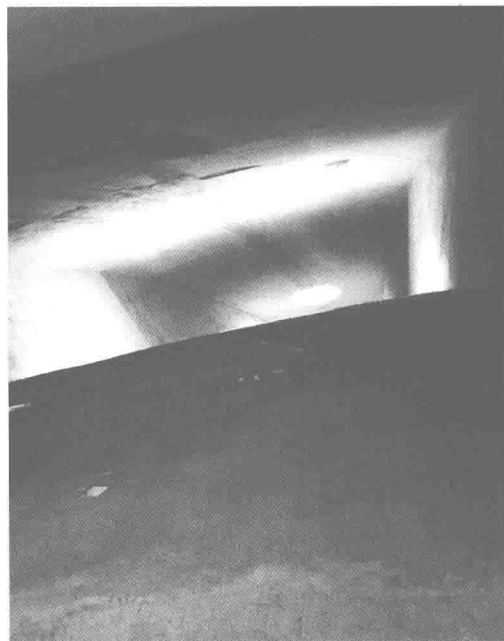
通向穹顶的道路在内外两层穹顶的夹层中
