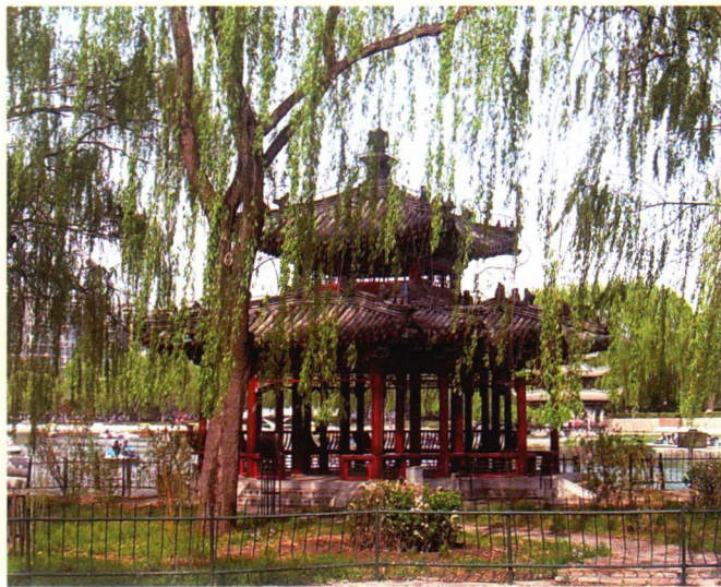
陶然亭重檐四角攒尖加抱厦烟雨亭
