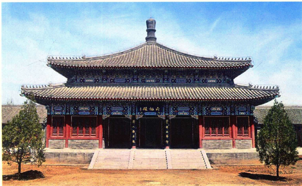
涿州六祖禅寺重檐四角攒尖七间六祖殿
