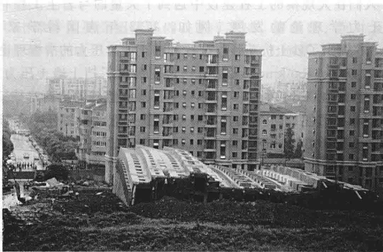
图 1.3 莲花河畔景苑 7 号楼
