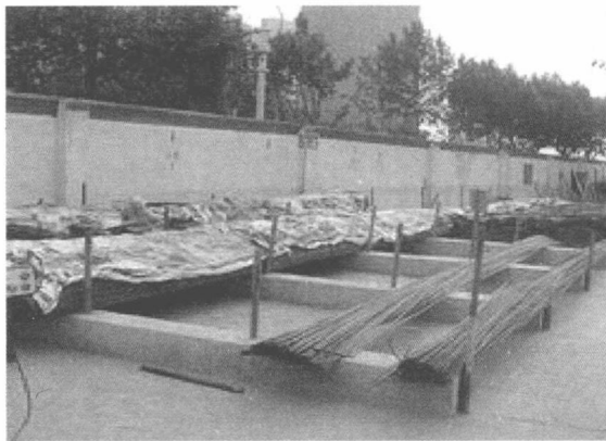
图 1-7 钢筋原材堆放区下浇筑混凝土土台，便于通风排水
