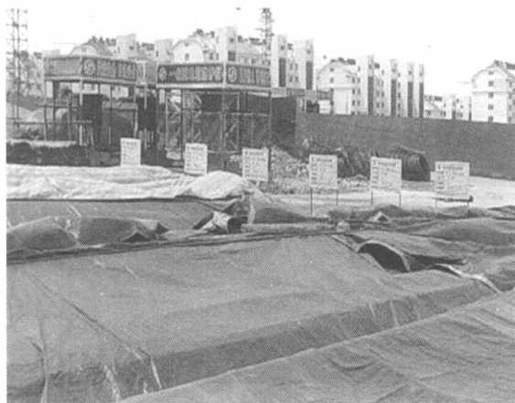
图 1-13 材料整齐，有防雨措施
