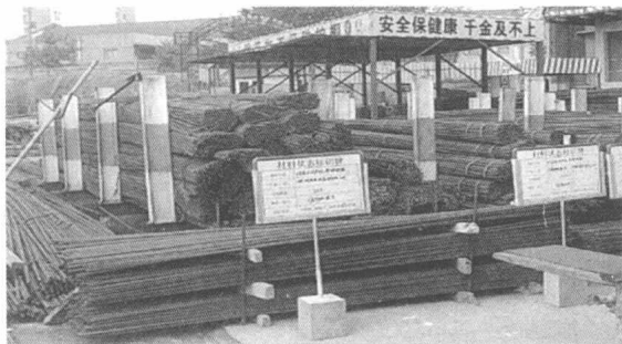
图 1-12 钢筋分类码放整齐，标牌规范、场地硬化，便于通风排水
