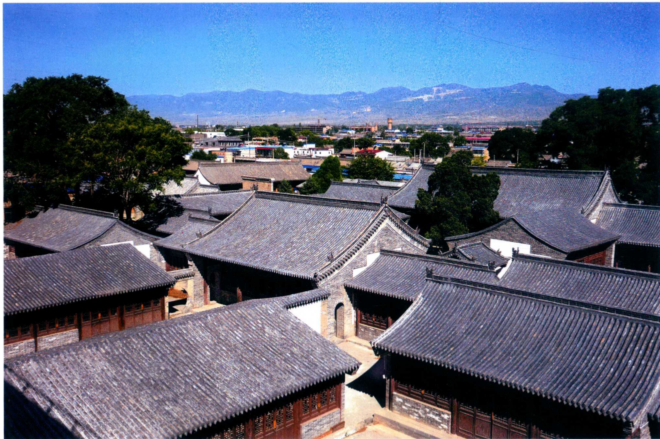
由杨氏古建公司维修复建的代州州衙建筑群
