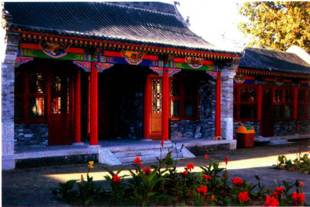
由杨氏古建公司承建的内蒙古鄂尔多斯市王府建筑群
