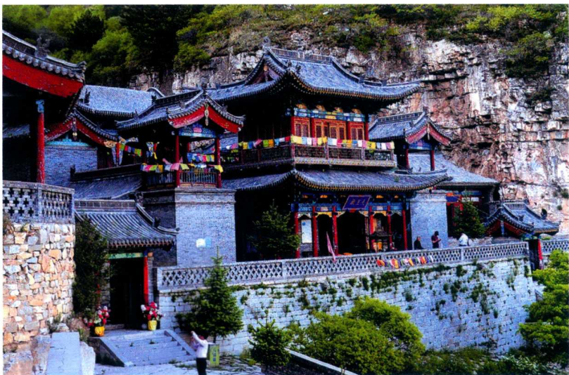
由山西雁门杨氏古建筑工程有限公司维修复建的白人岩禅寺建筑群
