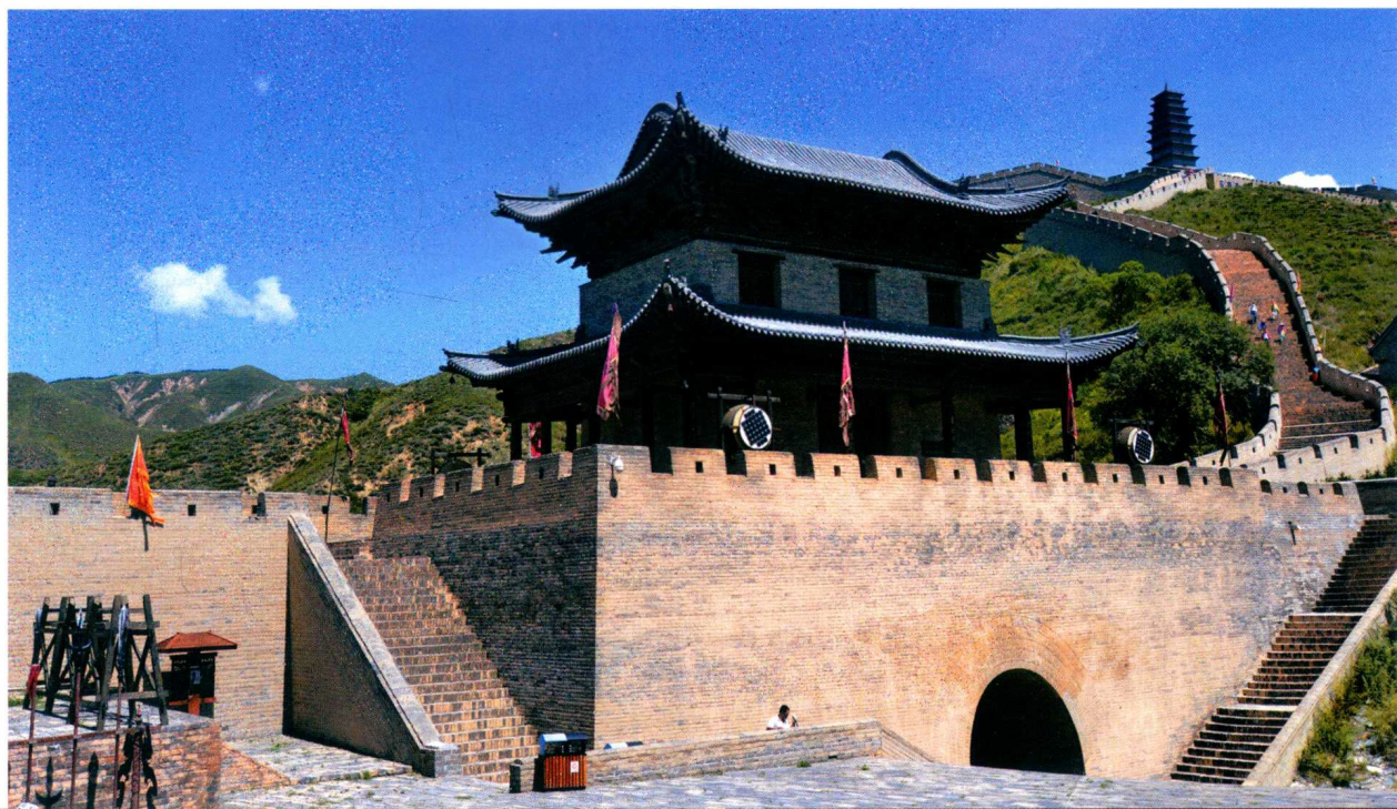
由杨氏古建公司维修复建的雁门关地利门
