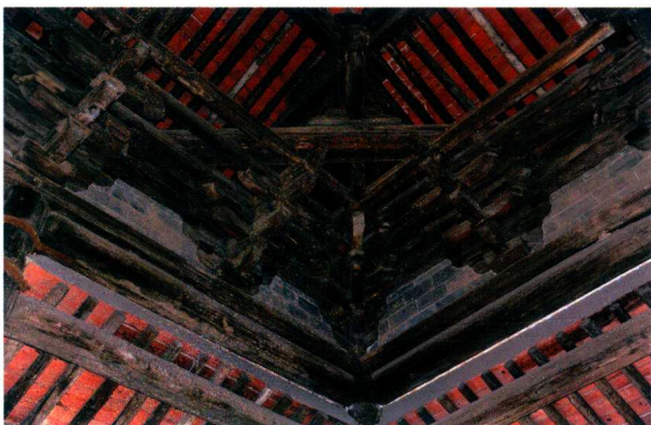
代县边靖楼的梁架斗拱
