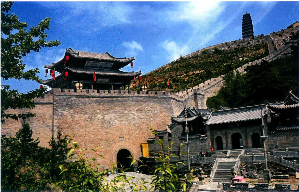
由杨氏古建公司维修复建的雁门关天险门和镇边祠
