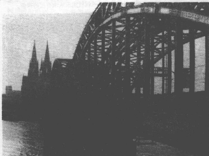
6b. 重建后的科隆。霍恩措伦大桥再次横跨在莱茵河上,恢复了连接河对岸大教堂的迷人景观。
