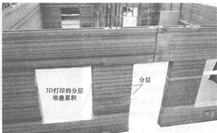
图 1-6 3D 打印中的分层堆叠累积
