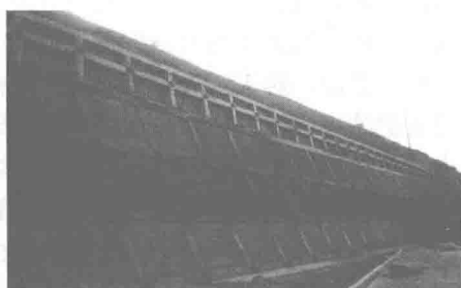
(b) 某大学支护边坡2
