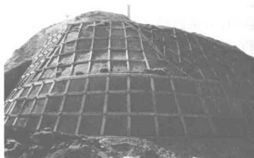
(a) 某大学支护边坡1
