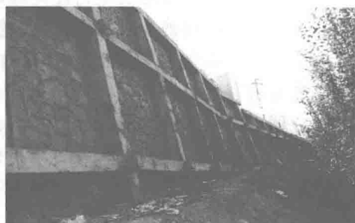
(d) 某加油站支护边坡
