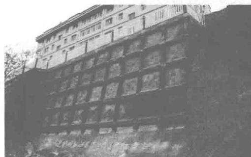
(c) 某住宅小区支护边坡
