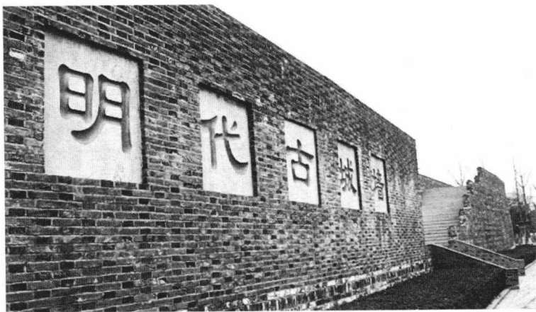
图 1-7 恢复修建的西 瀛门城墙 2
