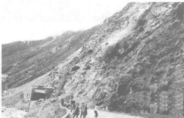
图 1-15 川藏公路滑坡现场
