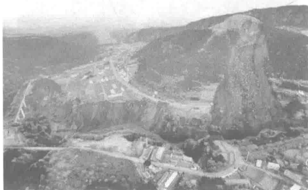
图 1-12 熊本县滑坡现场
