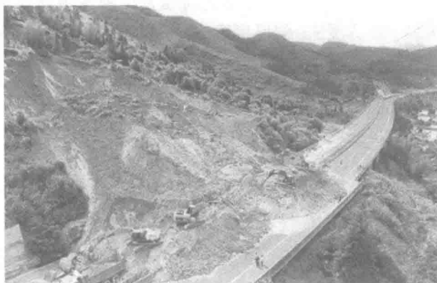
图 1-2 黔恩高速重庆黔江舟白段山体滑坡
