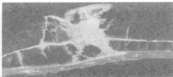
图 1-14 川藏公路滑坡航拍图
