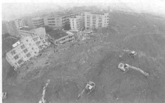
图 1-8 深圳市光明新区工业园滑坡现场航拍图
