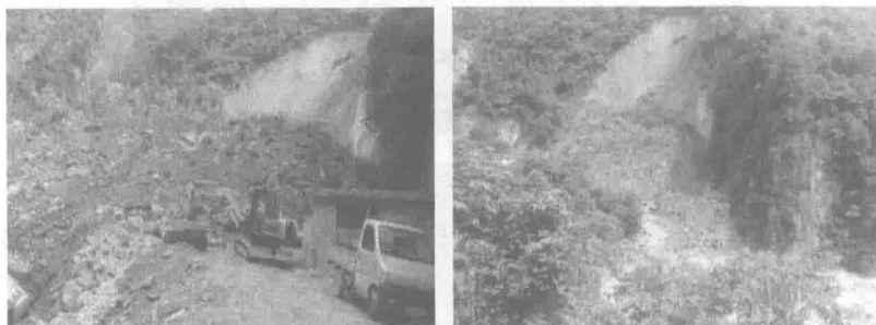
图 1-11 福贡县滑坡现场
