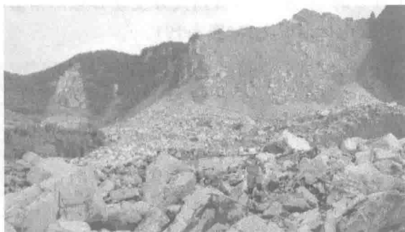
图 1-7 贵州毕节市纳雍县张家湾镇普洒社区大树脚组崩塌灾害
