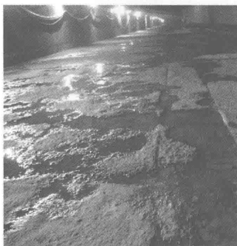
(a) 金沙江溪洛渡水电站导流洞
