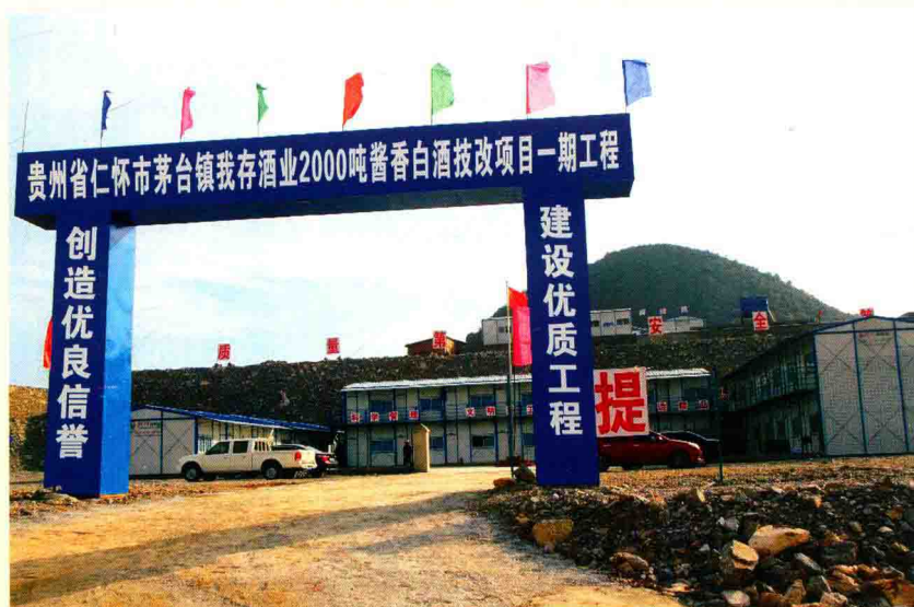
我存酒业有限公司年产2000吨酱香型白酒技改项目一期工程——现场施工图
