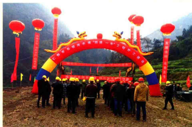
12月28日，仁怀市石坝河水库工程举行“四通一平”工程开工仪式
