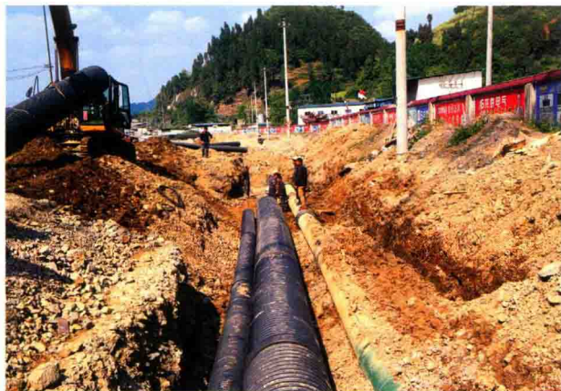
供水管道安装
