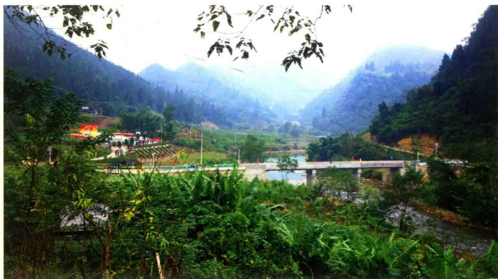
10月11日，众筹扶贫修建的沙坝河大桥正式通车
