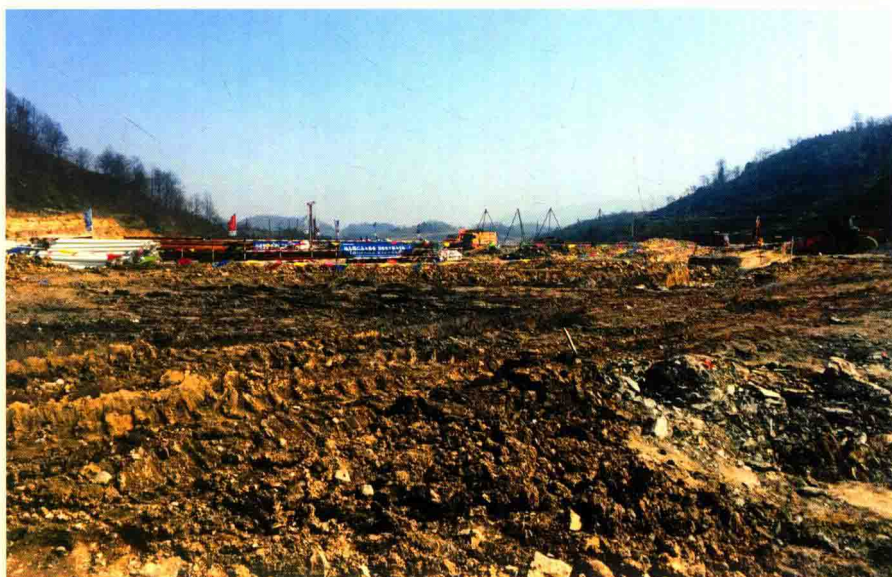
垃圾焚烧项目场地平整
