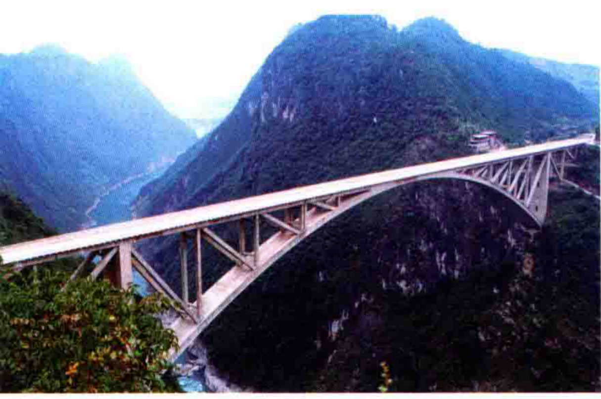
1995 年竣工的江界河桥
