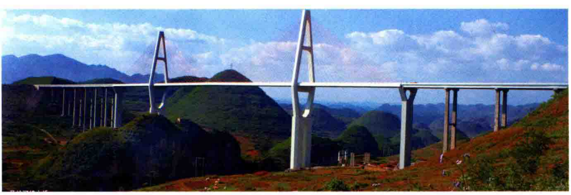
2009 年 10 月建成的马岭河特大桥
