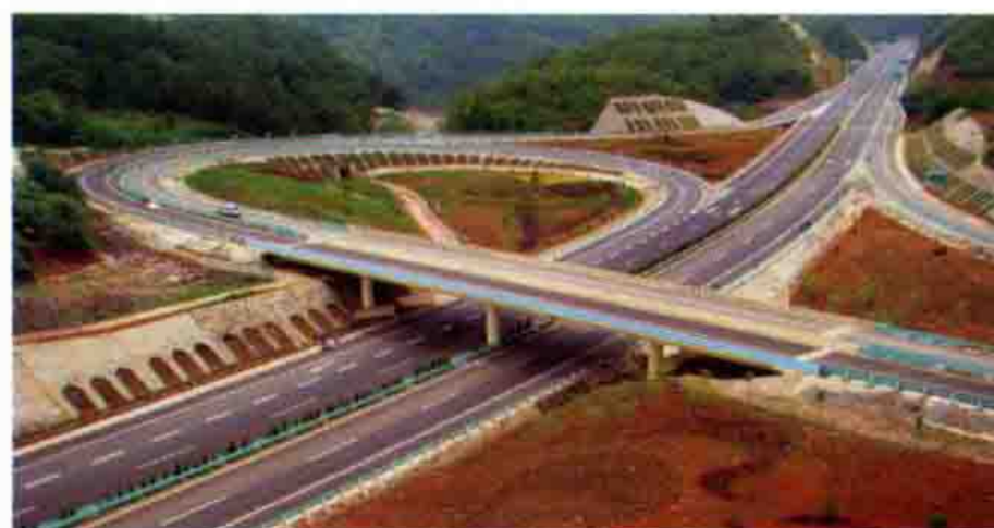
2009年底竣工的镇胜高速公路
