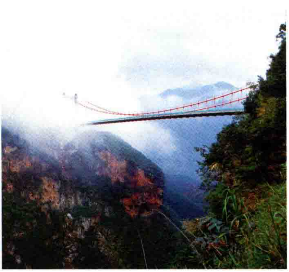
2003 年完工的水城阿志河大桥
